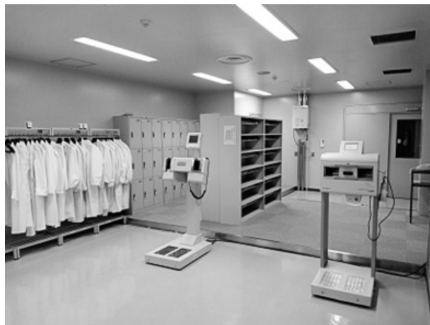
図4 教育訓練棟 汚染検査室
